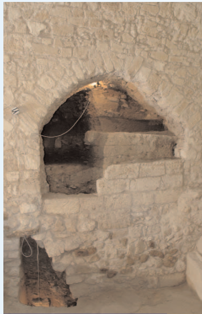
I due archi di scarico della galleria settentrionale
