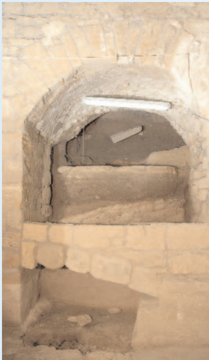
I due archi di scarico della galleria settentrionale
