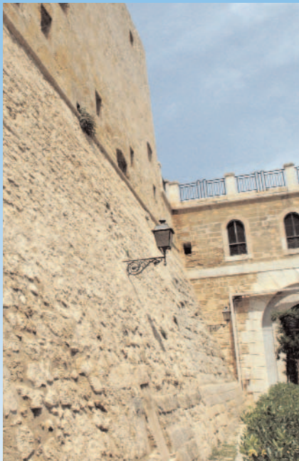
Il muro di Crispino contiguo al Ponte girevole
